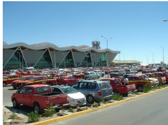
Vista general estacionamientos
