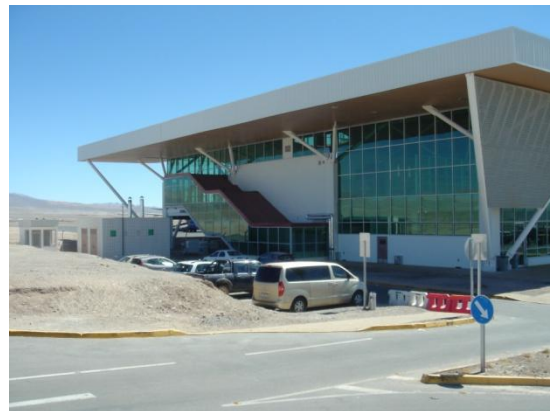
Vista costado oriente Terminal de Pasajeros
